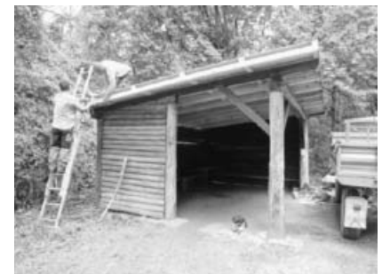
Die Waldarbeiter bringen das neue Dach an.
