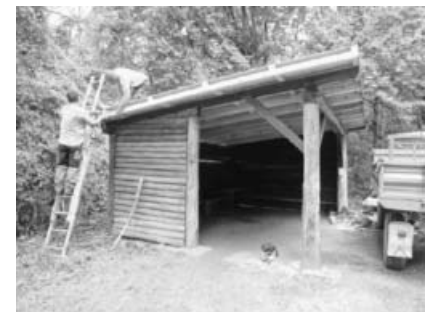
Die Waldarbeiter bringen das neue Dach an.
