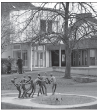
Schulzentrum in Sachsenheim mit der Kulturhalle, im Bildvordergrund Brunnenskulptur „Die sieben Schwaben“.
