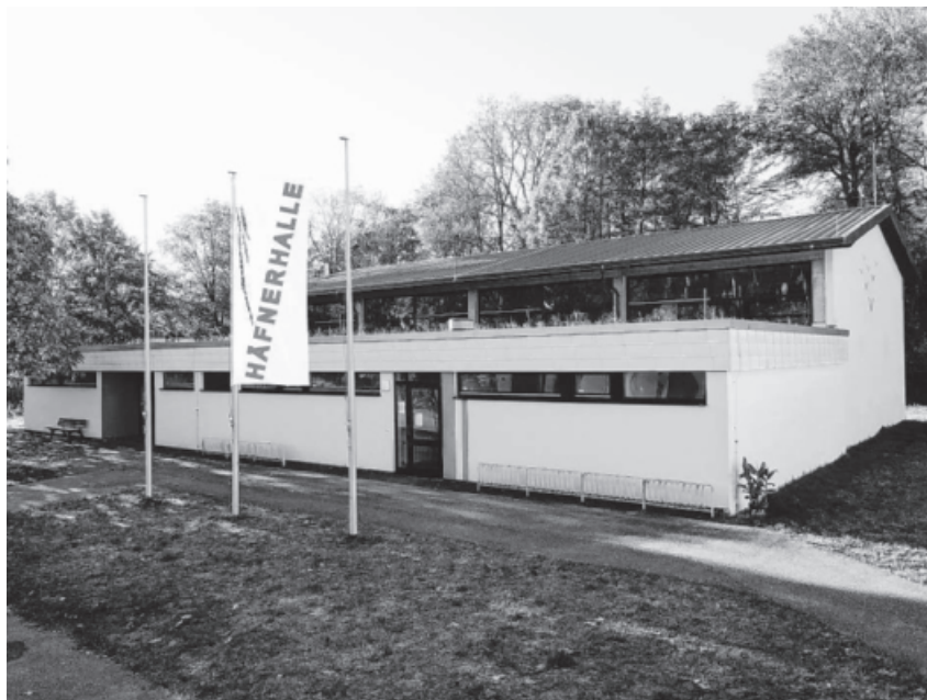
Die Häfnerhalle mit neuem Dach.
