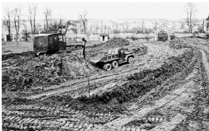
Errichtung des Freibades.
