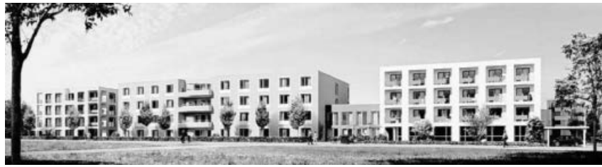
Ansicht von Süden: Viergeschossiges Pflegeheim (li) mit anschließendem zweigeschossigen Baukörper mit Cafeteria im Erdgeschoss.
