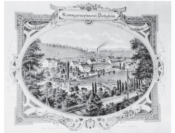
Die Fabrik um 1860. Foto: W. Wehnert.
