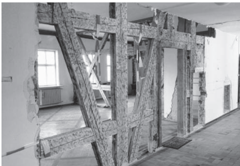
Zum Teil sind im Schloss schon Wände frei gelegt.
